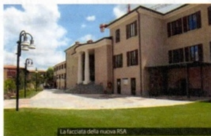
La facciata della nuova RSA
